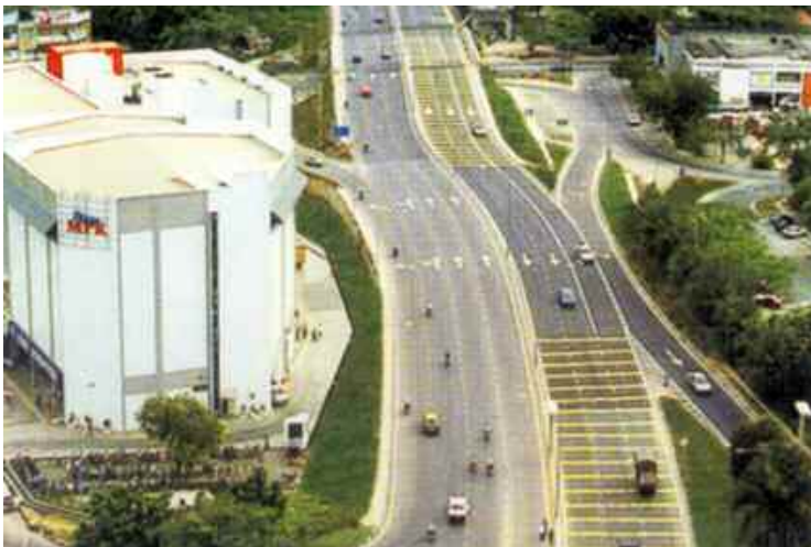
▲ Kota Bridge, Klang
